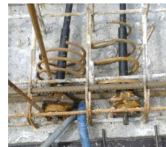
Figure 10 : Spire sur tête d'ancrage
