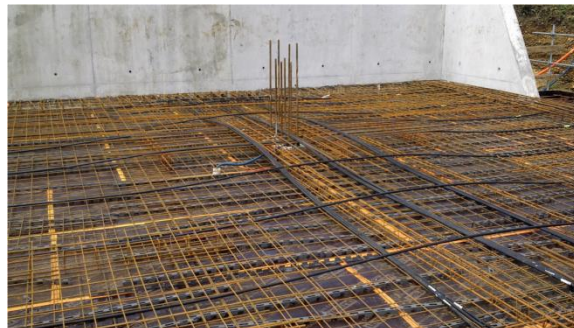
Figure 8 : Plancher ferrillé et câblé
