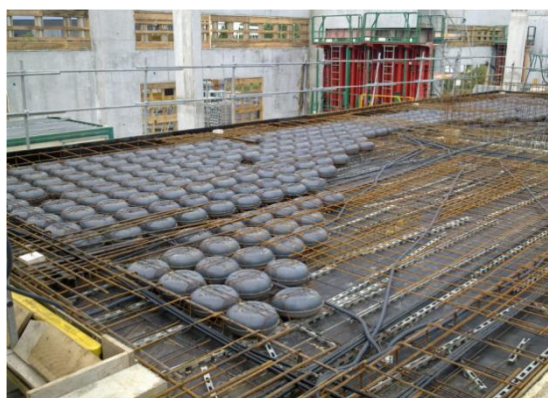
Figure 12 : Mise en oeuvre ballons de COBIAX
