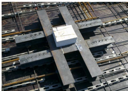
Figure 11: Platine pour fixation des suspentes
